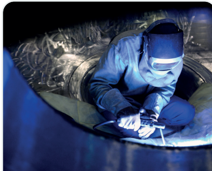
↑ Framatome, Schweißarbeiten an einem Dampfgenerator EPRT ©Nicolas De Lepierre/ Framatome
