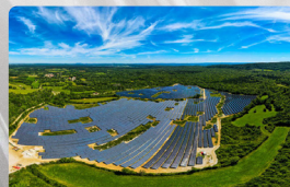
Ferme solaire Picarreau © Corsica Sole
