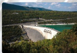
Barrage de Vouglans © D. Maraux
