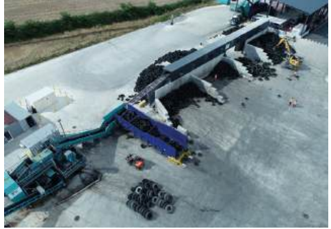
Systeme de tri Regom - Cercy-la-Tour © TC environnement
